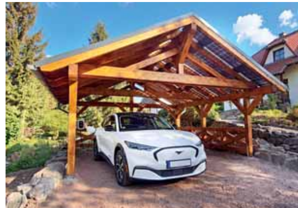
Stellplatz mit Ladeanschluss: Mit Solarmodulen wird der Carport zur privaten Elektrotankstelle.
